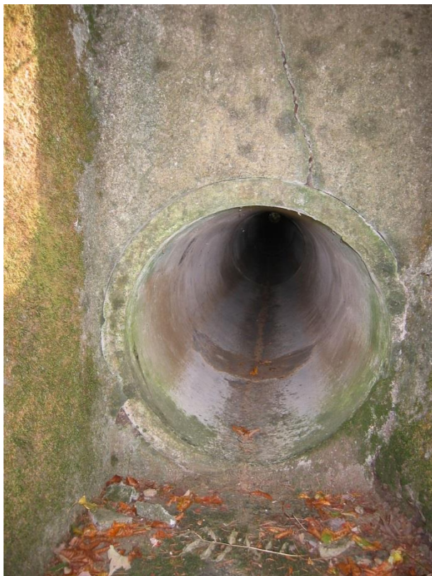
Foto 3: DN500 Betonröhre (in Gegenfliessrichtung)
